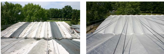
Abb. 3: Dachaufsicht mit Zugseilkonstruktion vor und nach der Sanierung
