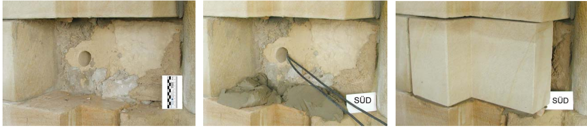
Bild 7, 8, 9: Einbau des „Sensorsteins“
