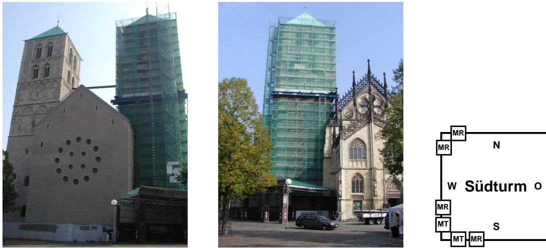
Bild 1, 2, 3: Dom Münster mit eingerüstetem Südturm und Lage der Sensoren im Südturm
