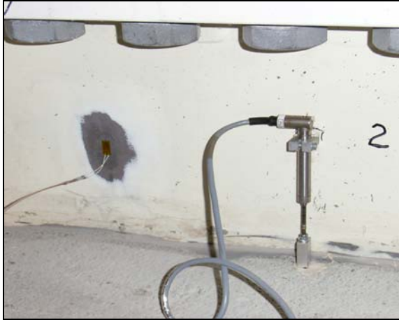
Abb. 10: Messung am Fundamenteinbauteil
