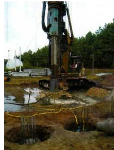
Abbildung 5: Herstellung der Pfähle
