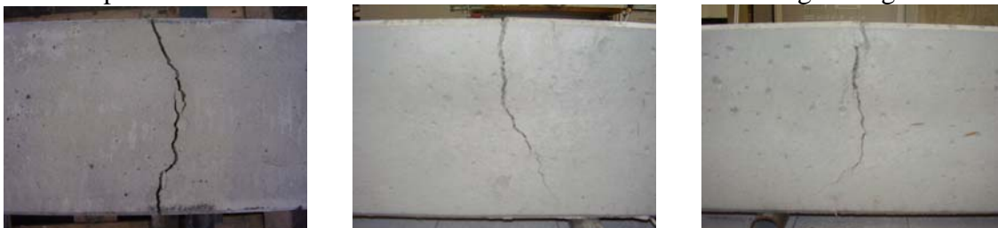
Abbildung 12 Testkörper „QSR6b“, Rissverlauf bei x = 550 mm. Links: Draufsicht, Mitte: Ansicht der Vorderseite, rechts: Ansicht der Rückseite
