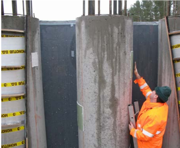
Abbildung 6: Anbringen der Fehlstellen an die bewehrten Pfähle.
