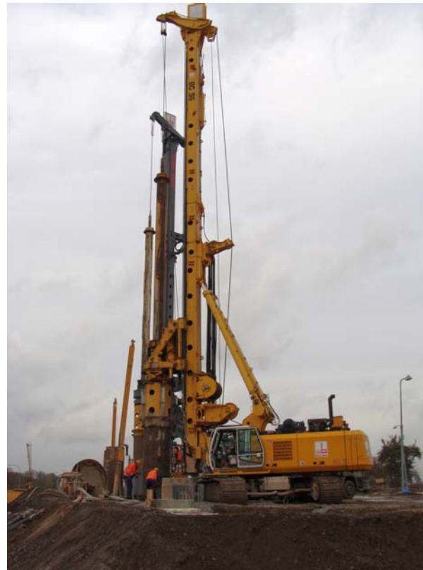
Abbildung 3: Bau einer überschnittenen Bohrpfahlwand an einer Schleuse in Norddeutschland.
