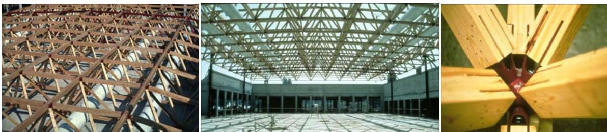
Abbildung 1: Seeparkhalle in Arbon, CH (1984) [Fotos von A. Bernasconi]
