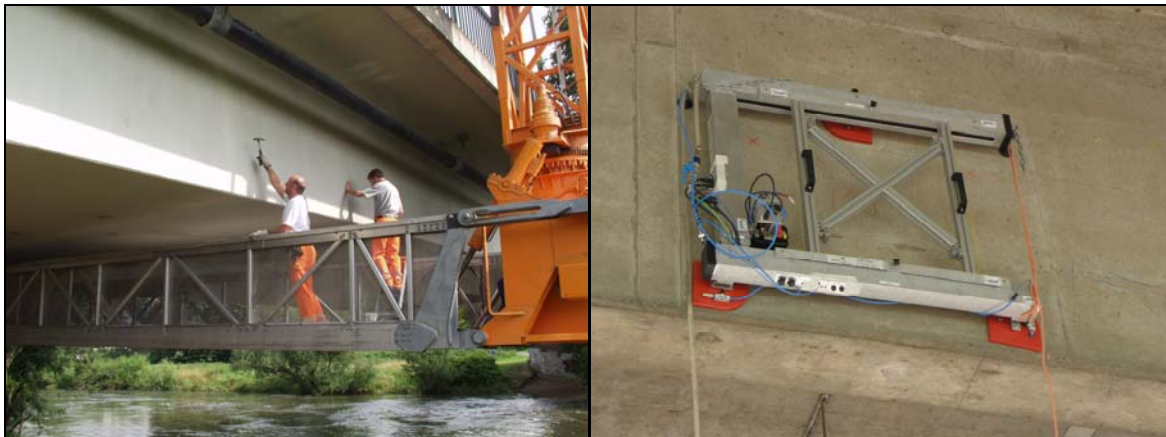
Abb. 2 visuelle Bauwerksprüfung und Brückenscanner
