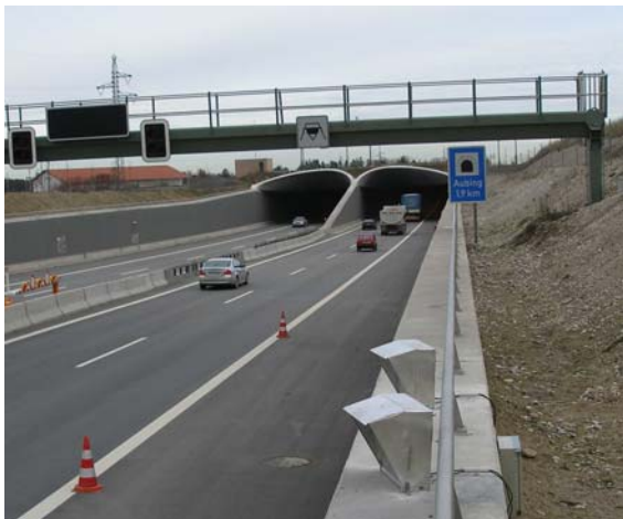
Bild 5: Hydrophobierte Einfahrtsportale und Probeplatten
