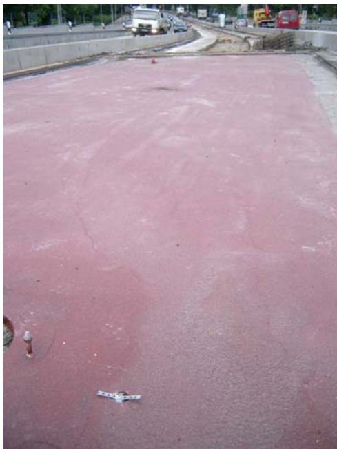
Bild 3: Vorbereitete MRE auf grundrierte Brückentafel (links Brückenablauf)
